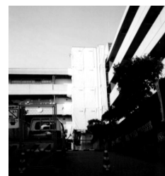
↑完成待たれるエレベーター
